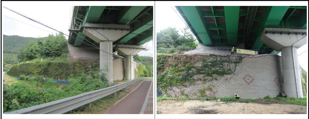
【그림 10.3.1】 전면부 전경(보강토옹벽)
